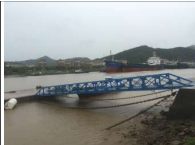
西岸码头南侧（山体）
