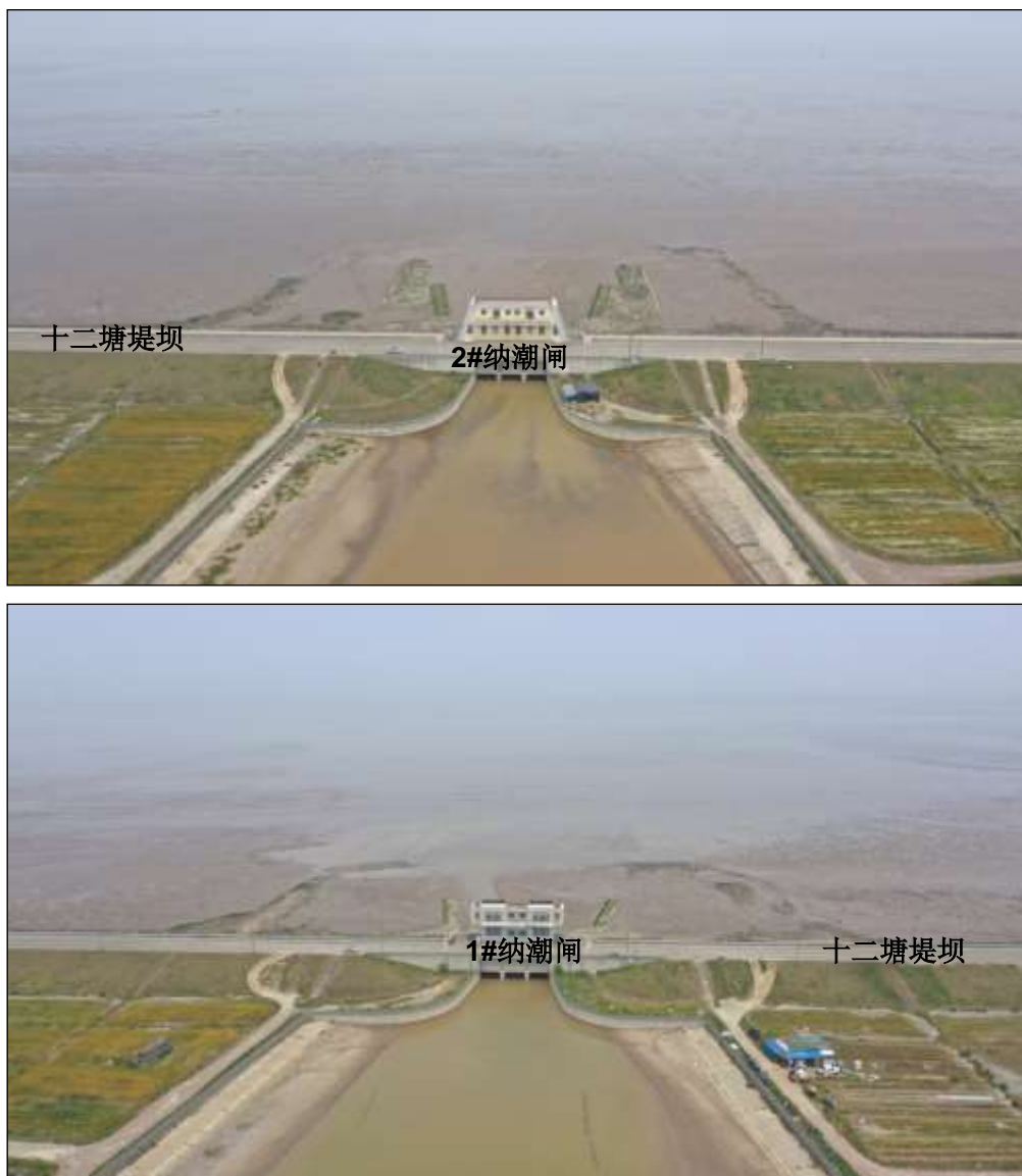
图 2.1-2 工程附近现状照片
