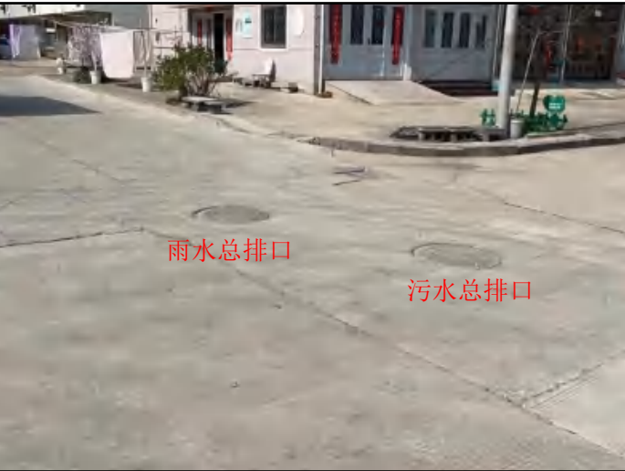
雨、污水总排口
