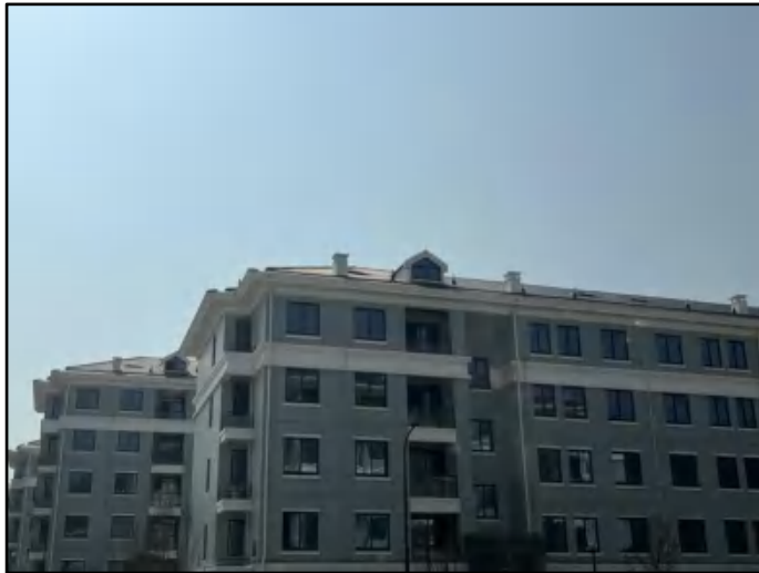
厨房专用烟道
